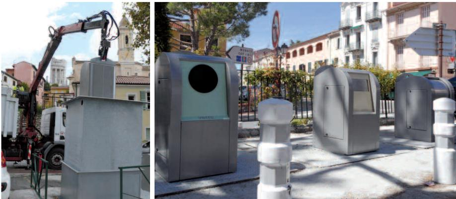
■ Un camion grue vient régulièrement vider les caissons de 5m<sup>3</sup> enterrés en centre ville.
