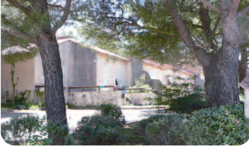
Les anciennes villas du Centre National d'Études des Télécommunications (CNET) seront démolies pour laisser la place à une structure hôtelière de luxe et spa.
