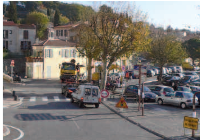
La mise en sécurité des piétons empruntant l'Avenue de Cap d'Aïl était devenue une priorité. Un feu tricolore est installé le temps des travaux qui devraient être livrés troisième semaine de décembre.
