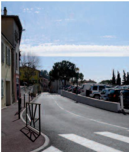
■ Un carrefour sécurisé – En haut de la route de Cap d'Ail, la commune a aménagé cet hiver un long plateau traversant ainsi qu'un cheminement piétonnier protégé (côté Est). Côté Ouest, elle a refait le mur de du parking et l'a équipé de bandes réfléchissantes.
