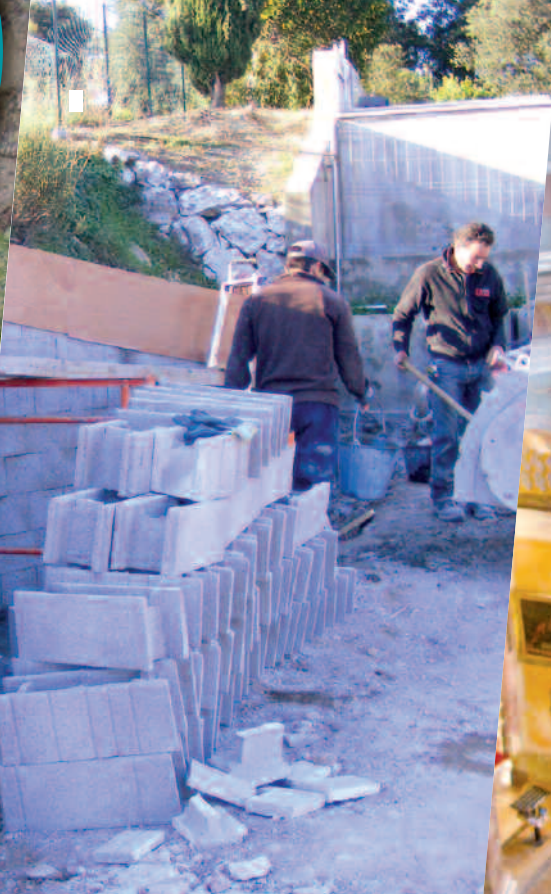
La réalisation d'un colombarium au cimetière sera acheuée en février.
