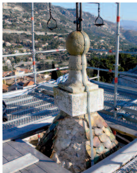
■ Une par une, les tuiles vernissées abîmées du clocher ont été refaites à l'identique et à la main. Photo : Pierre Simond
